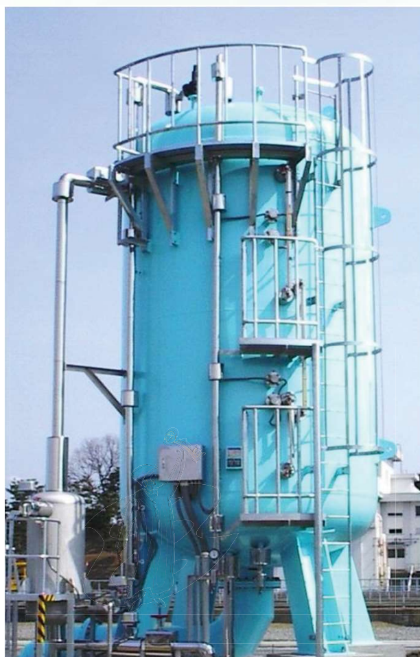
北九州市水道局納 4.0 m 3 空気補給式エアチャンバ
